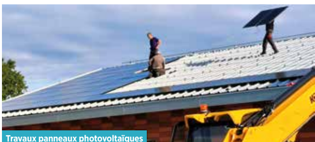
Travaux panneaux photovoltaïques
